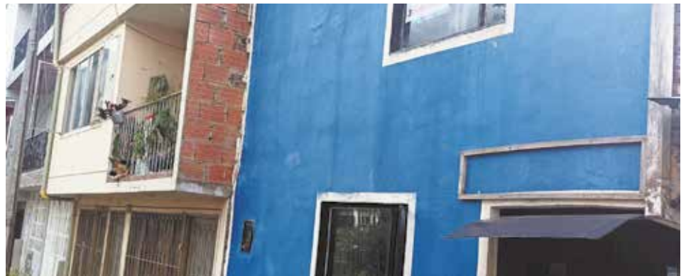
Subia, Sylvania Cundinamarca. Lote de 7x15. Casa construida de 5x5 . Barrio La Florida, A una cuadra de La panamericana. Servicios completos $220M. Info. 3006029844
